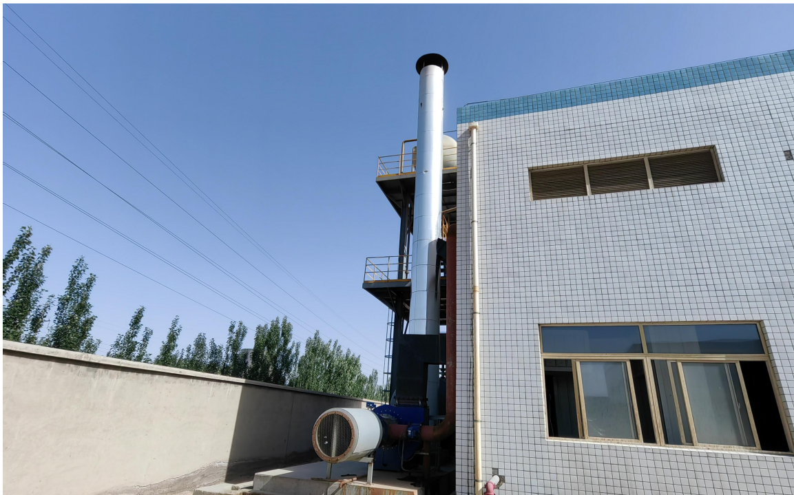
图 4.1.1-8 导热油炉废气排放口
