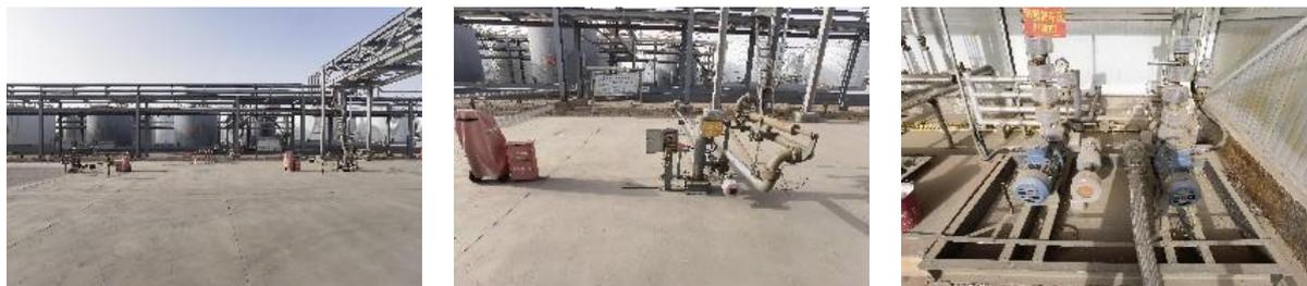
(2) 乙类罐区（罐组三）装卸区：鹤管、传输泵
