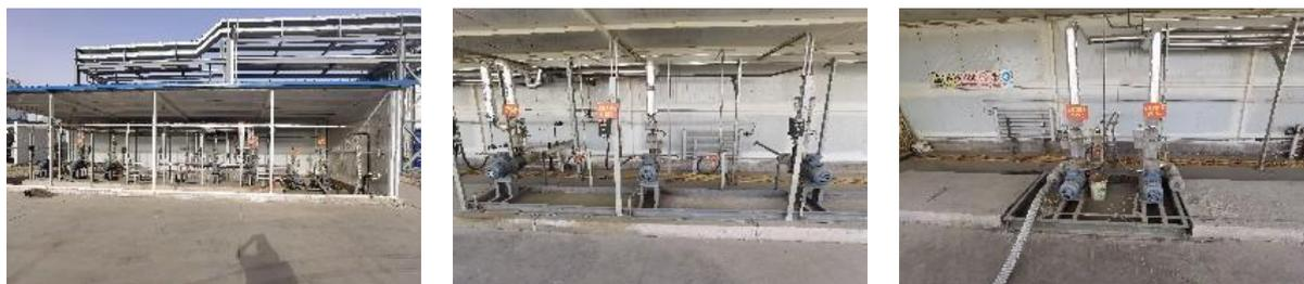
(3) 乙类罐区三装卸区：鹤管、传输泵
