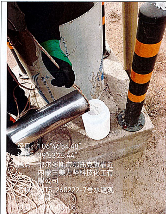
7号水源观测井
